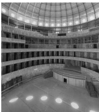
19 Situazione attuale della cavea: le strutture sono completate manca l'apparato decorativo (ex.novo)
