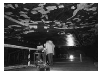
16 Velinatura e messa in sicurezza del soffitto e della tela dell'Armenise
