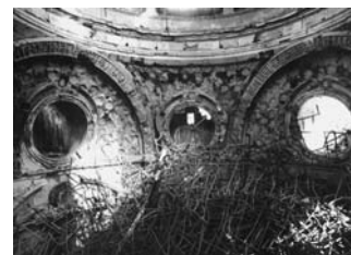
21 La cappella dopo l'incendio
