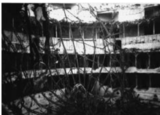
13 La sala Teatrale prima e dopo il devastante incendio
