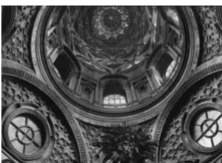
20 La cappella prima dell'incendio
