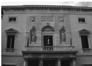
11 Completamento intervento sulla facciata
